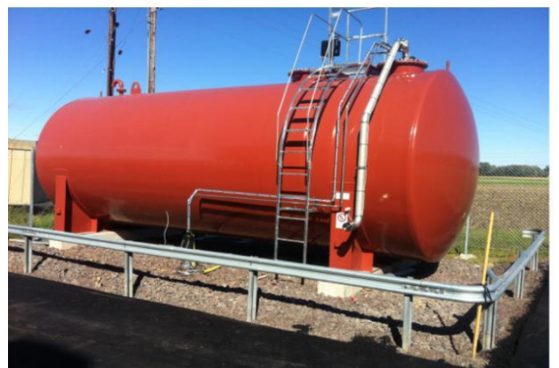
50 м 3 резервуар с диаметром 2900 мм. Лестница и платформа. Заполнение снизу.
