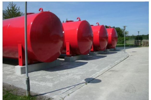
4 x 100 м 3 резервуары с диаметром 2900мм.
